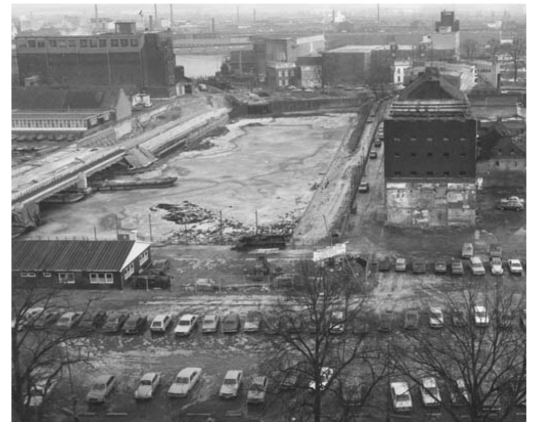
Aanleg van bassinbrug en gesloopte panden ca. 1979
