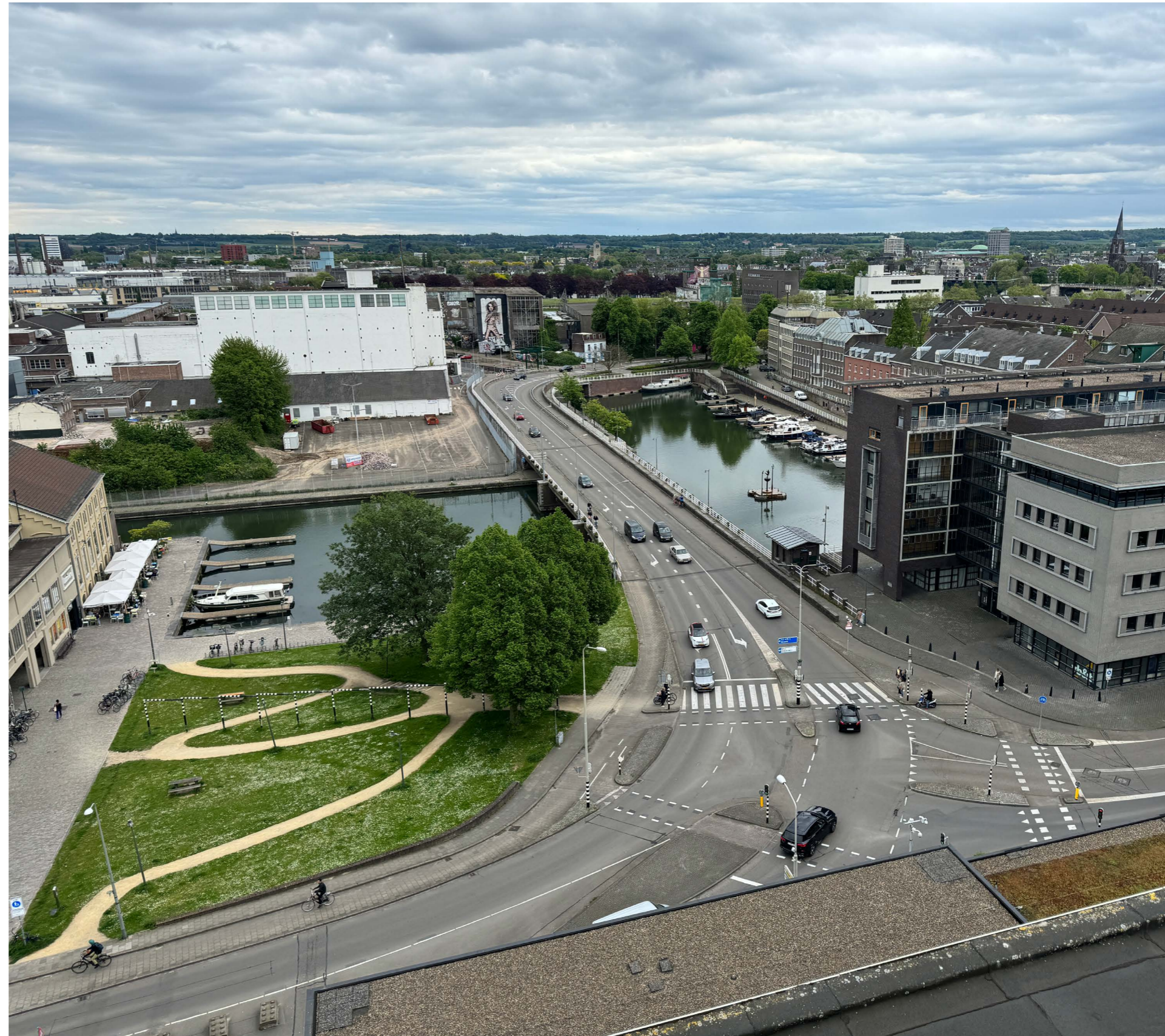
Foto huidige situatie bassinbrug gezien vanuit de Sphinx fabriek
